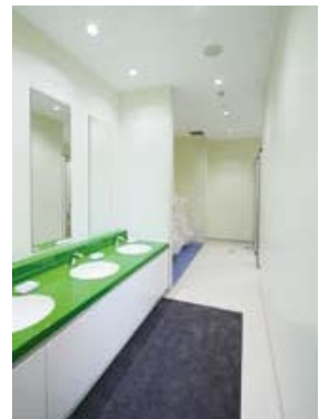
自動点灯するトイレの照明
